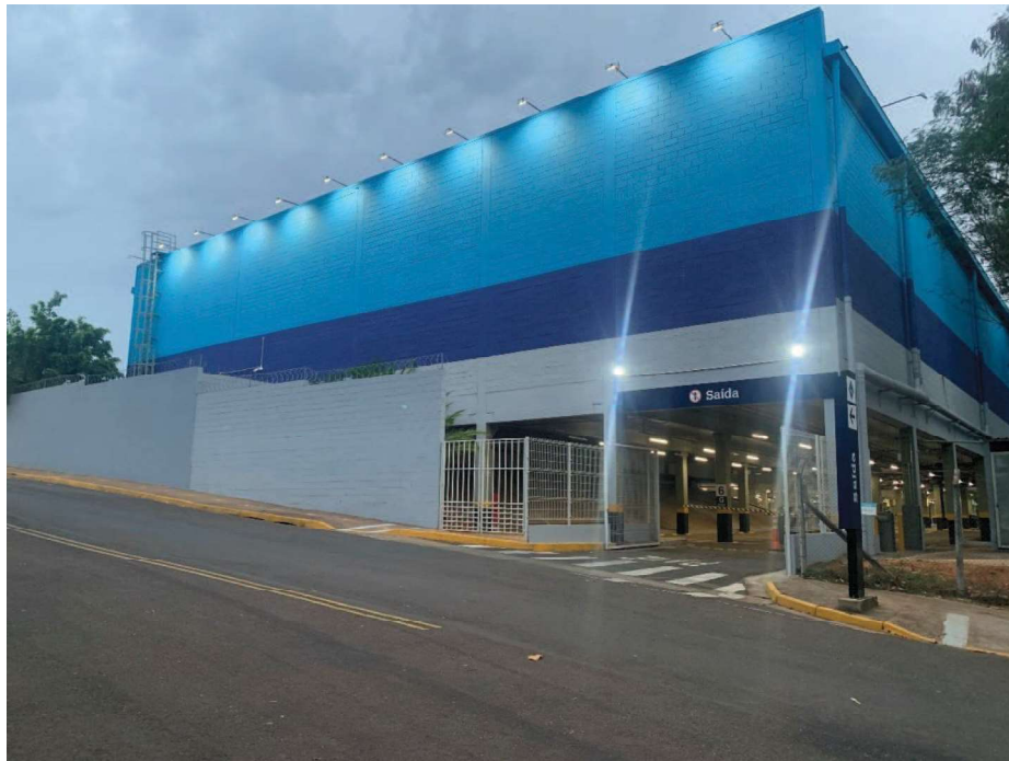
Vista lateral do imóvel periciado
