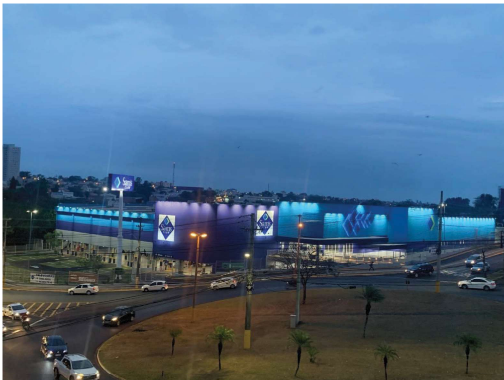
Vista panorâmica do imóvel periciado
