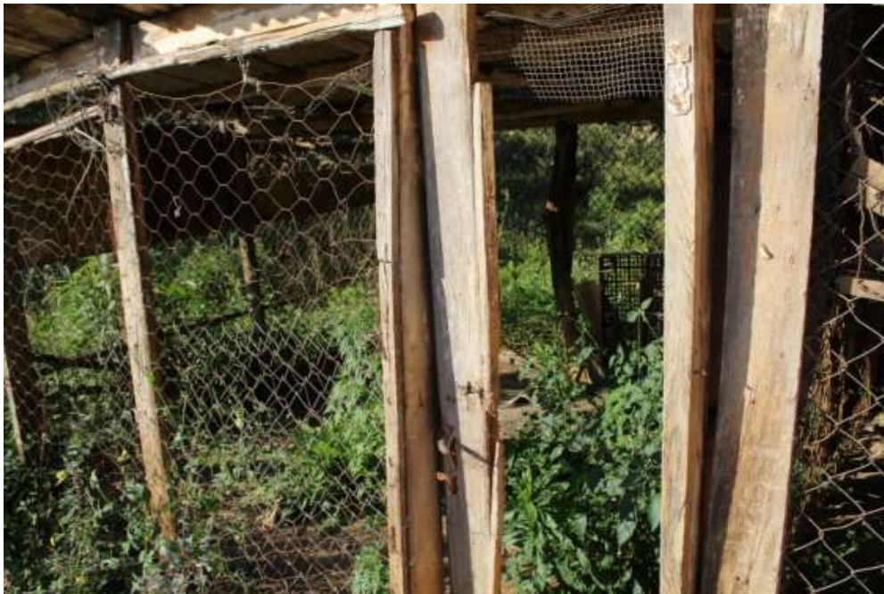
Foto 14 – Edificação rudimentar na parte baixa do imóvel
