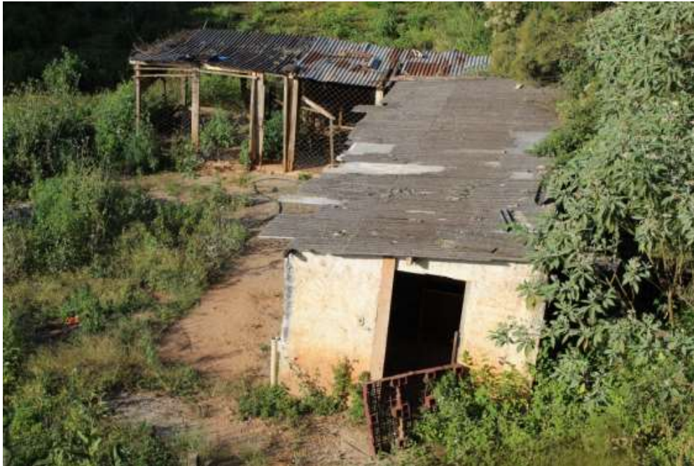
Foto 11 – Edificação rudimentar na parte baixa do imóvel
