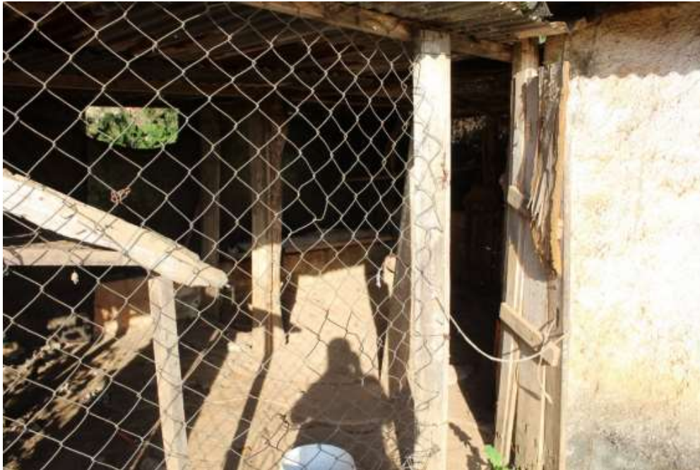
Foto 13 – Edificação na parte baixa do imóvel (local sem uso, aparenta ser destinada a criação de animais)
