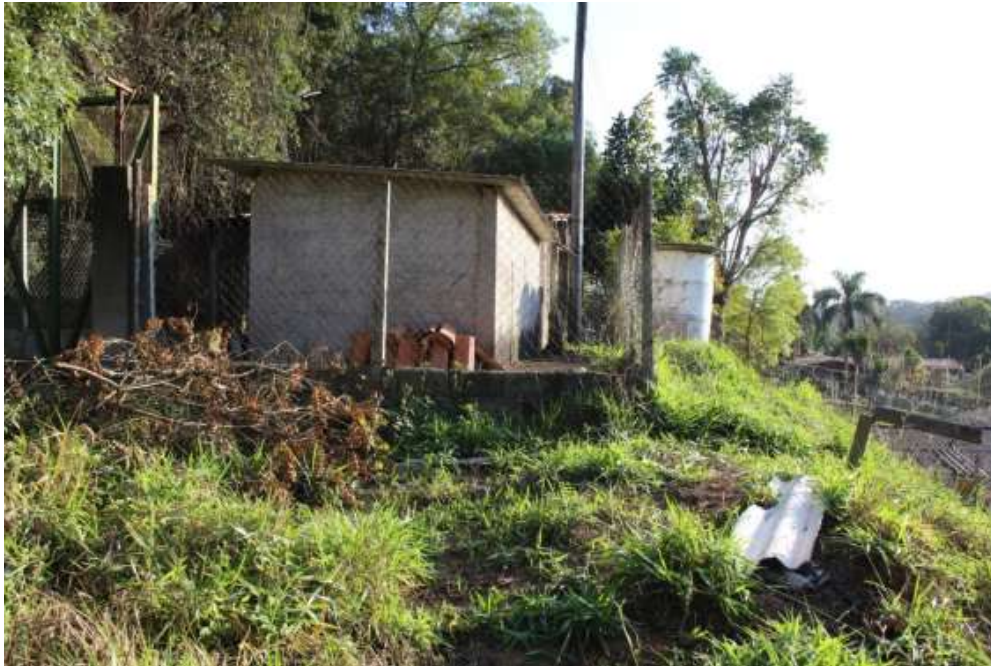
Foto 5 – Visão da pequena edificação na entrada do imóvel
