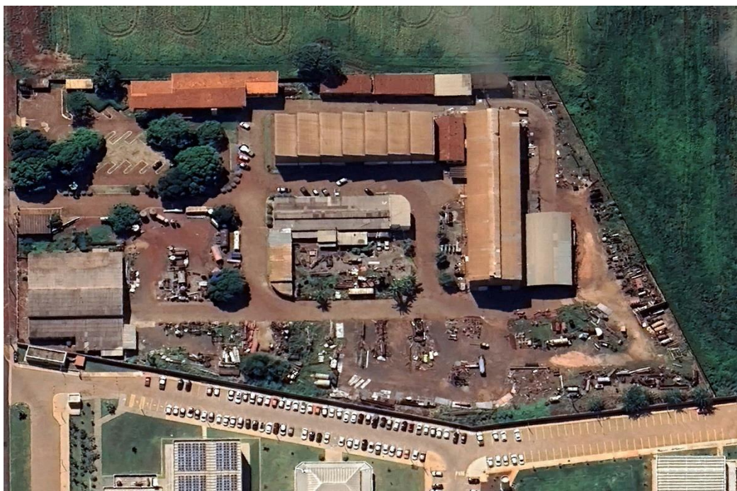
Muro de divisa e alambrados
