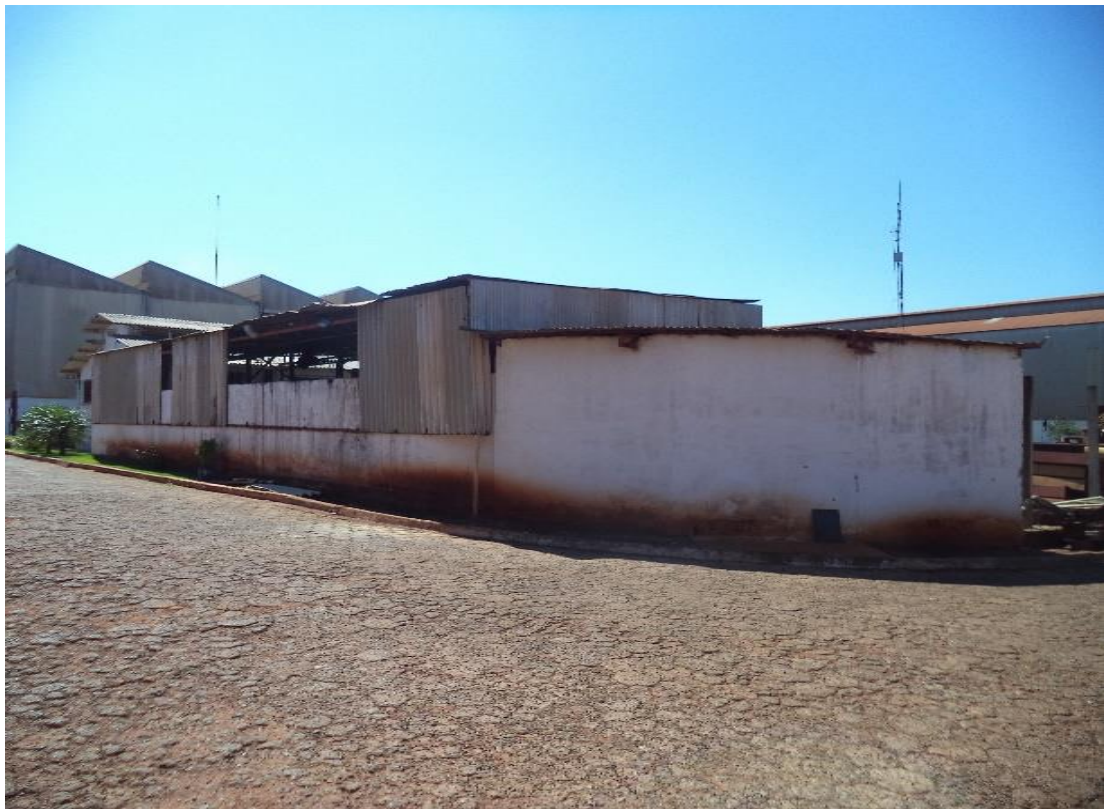
Barracão anexo ao Prédio Industrial
