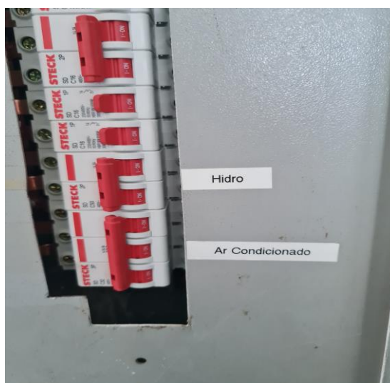
10° andar – quadro elétrico atualizado e dentro da norma
