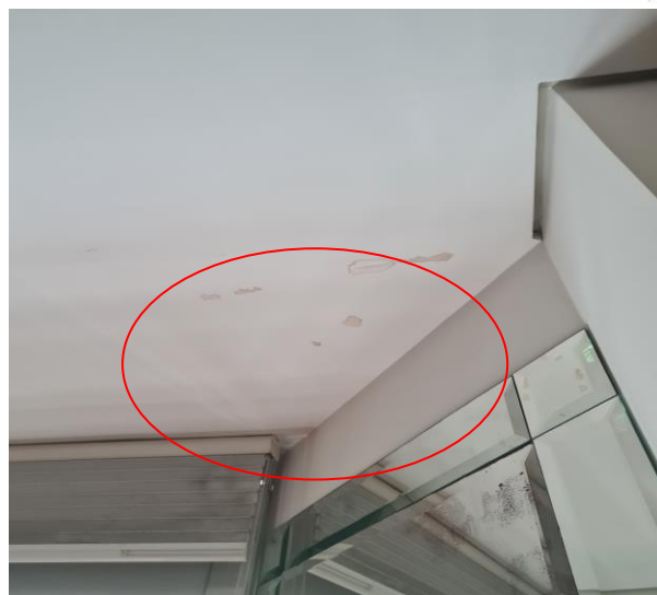
9º andar – quarto 2: divisa íntima: possível infiltração do ofurô do pavimento superior (10º andar)
