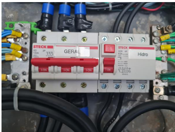
10° andar – quadro elétrico atualizado e dentro da norma
