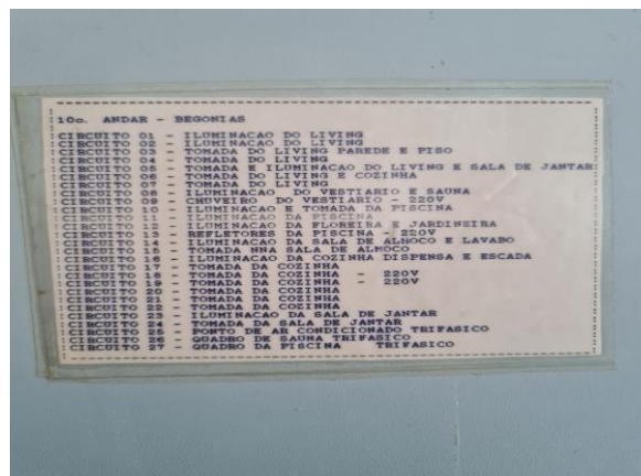
10° andar – quadro elétrico atualizado e dentro da norma
