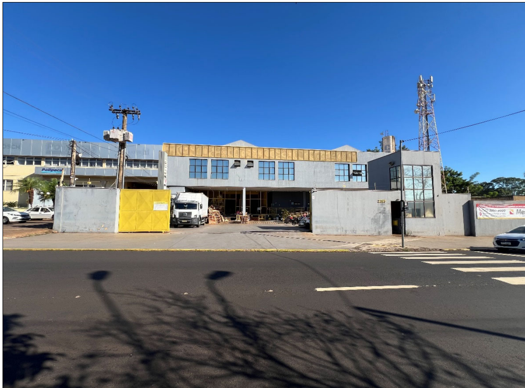
FOTO 01: Fachada do imóvel.
