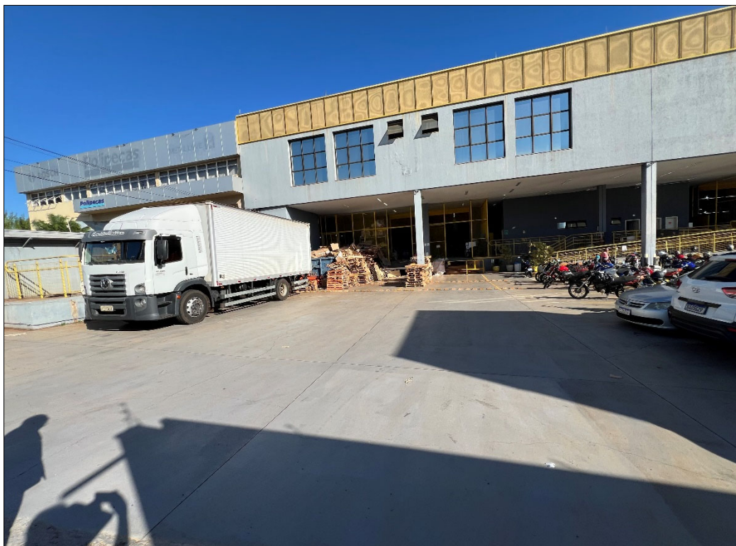
FOTO 03: Parte externa da frente do imóvel.
