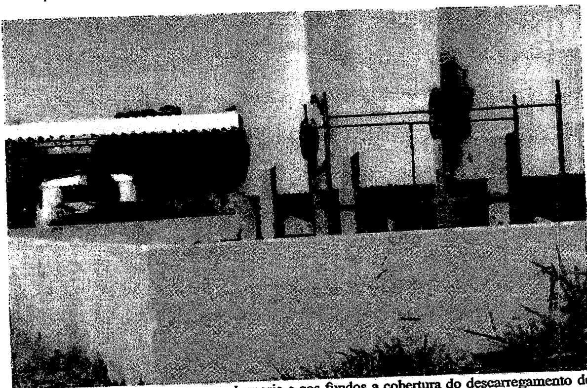
Foto interna da parte de descarregamento, e no destaque o piso de concreto e a mureta de contenção de alvenaria.
