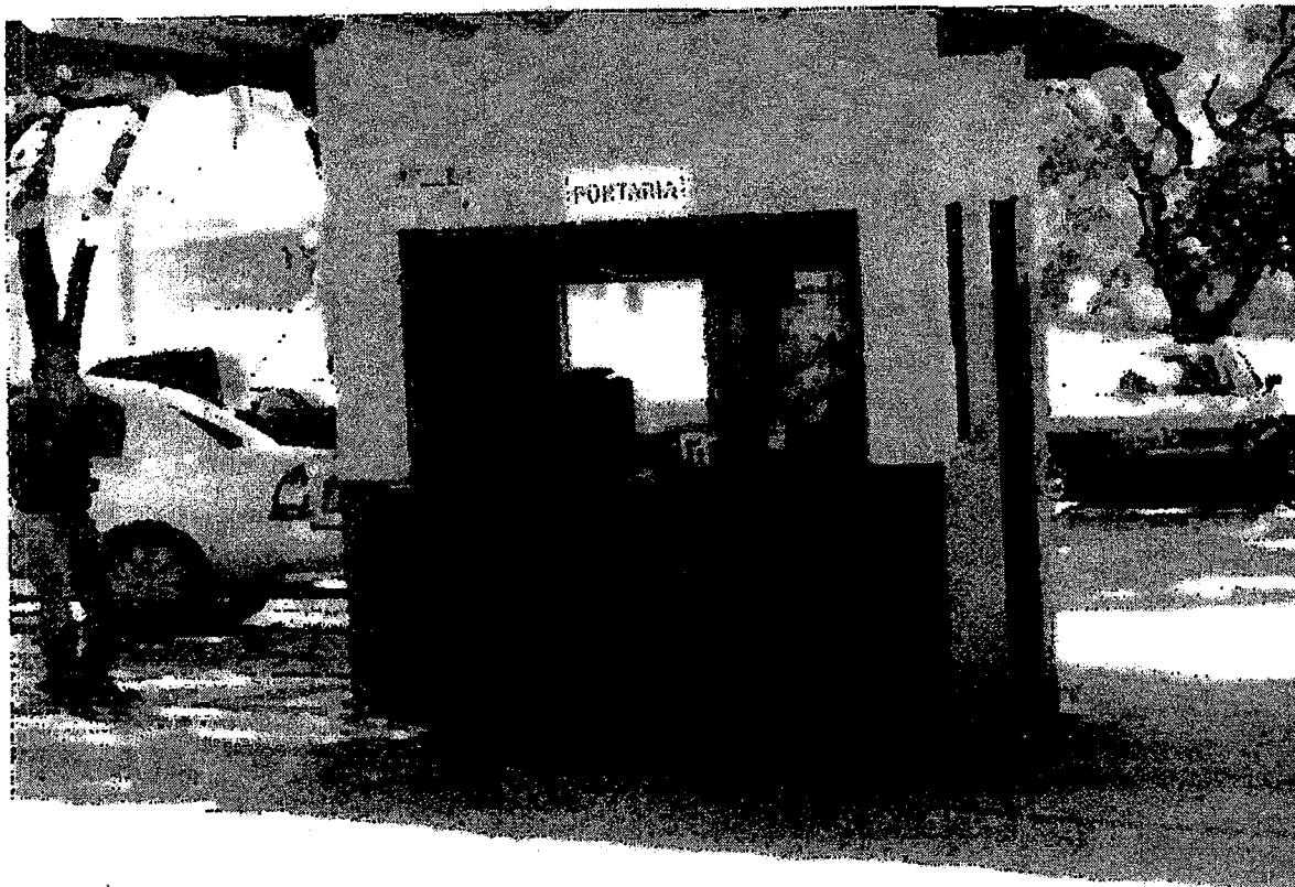
Foto frontal da portaria (guarita) e detalhes construtivos.
